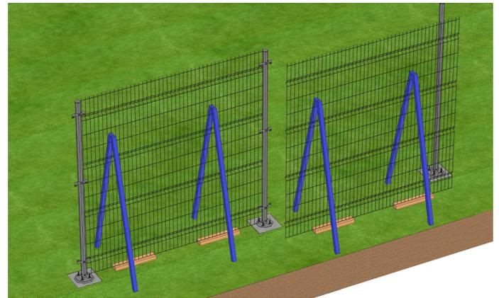
Установите третью опору в подготовленную яму и несущий столб на опору (по аналогии с предыдущими шагами), навесьте секцию. Закрепите секцию деревянными распорами и брусками. Засыпьте опоры щебнем и залейте бетоном.
